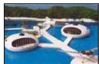
Элементы домов изготавливаются из нового типа предварительно напряженного армированного бетона с легко трансформируемым керамическим наружным слоем; они практически не требуют технического обслуживания, огнеупорны и устойчивы к любой погоде. Эти сооружения с тонкой железобетонной оболочкой могут производиться за считанные часы. С таким типом конструкции ущерб от землетрясений и ураганов будет минимален.
